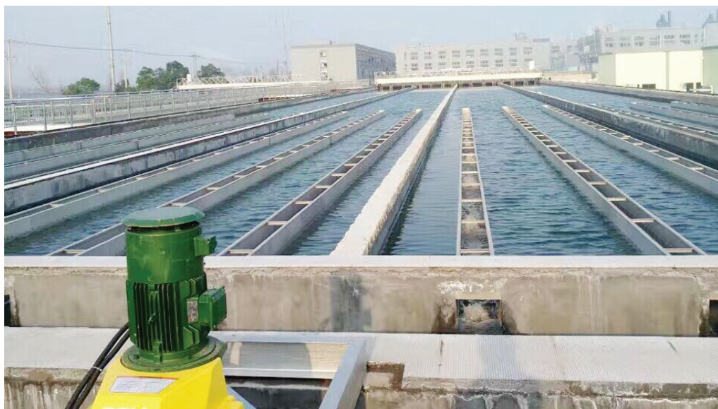
从2016年12月29日开始,滨海第二水厂一期工程正式进入手动联体调试环节,这标志着该工程基本建成,也意味着滨海工业区内“二厂二网”的供水格局正式形成。(滨海供水公司 钱萍 摄)
