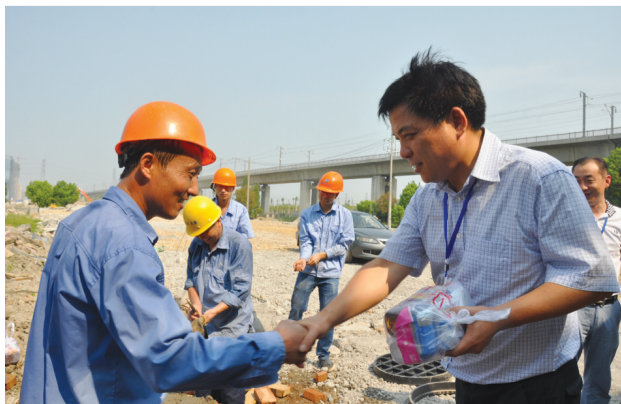
图为董事长周俭慰问供水管道安装工(供水公司 平晶晶 摄)
